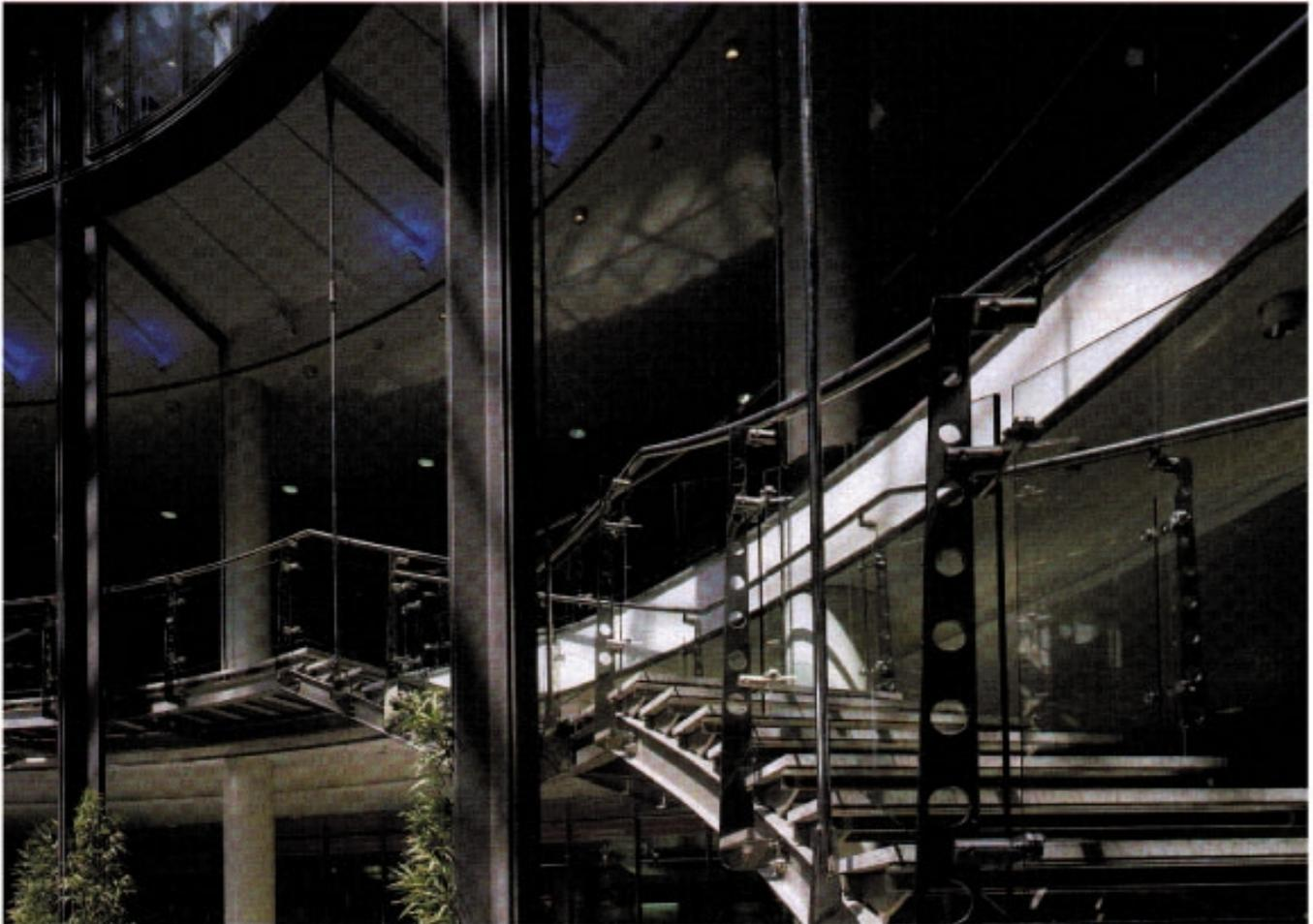
Neubau Börse, Zürich: gewundene Metalltreppe in glasperlgestrahltem Chromstahl. Geländerkonstruktion in hochglanzpoliertem Chromstahl, Geländerfüllung in Ganzglas-Sicherheitsglas.
