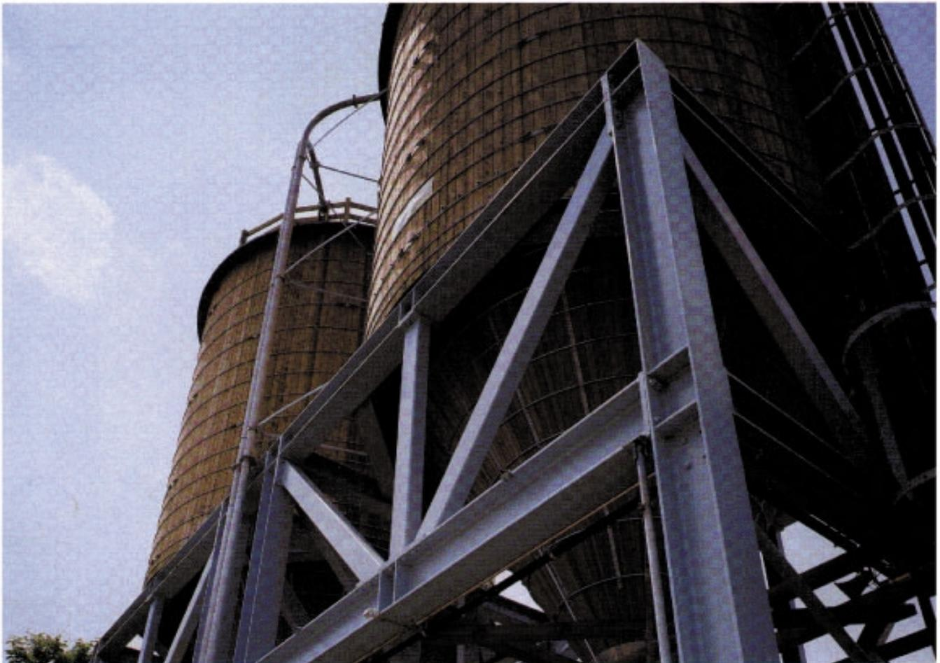
Werkhof N3, Wädenswil: Stahlkonstruktion für Salzsilo, feuerverzinkt, mit speziellem Korrosionsschutz.
