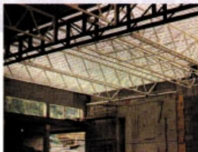
Dreifachturnhalle, Kantonale Berufsschule Goldau: Stahlbinder für Dachkonstruktion, Dach mit schallhemmenden Blechen.
