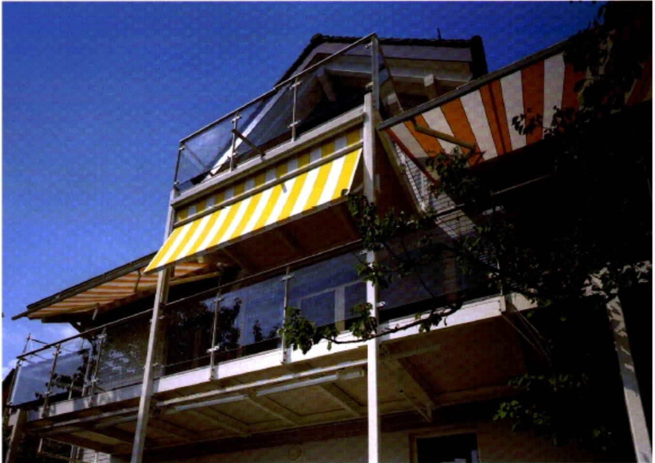
Verglaste Balkonkonstruktion, einbrennlackiert. Mit Sonnenschutz.
